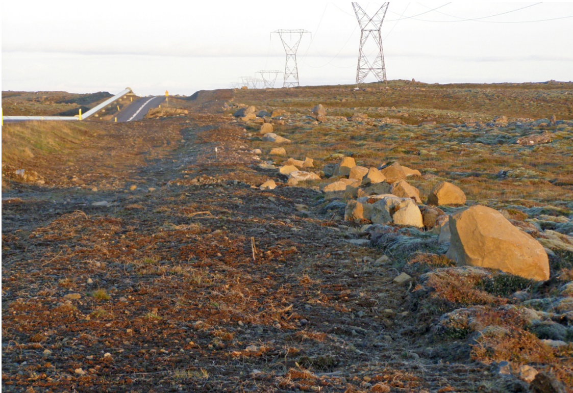
Mynd 6. Á Mosfellsheiði. Steinar sem fjarlægðir voru úr skurðstæðinu voru lagðir í móann handan skurðsins.
